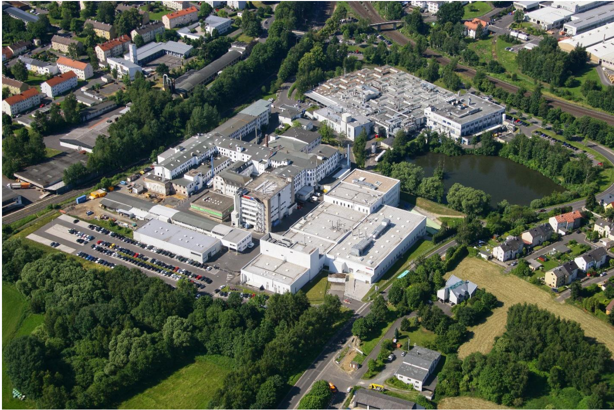
Standort Marktredwitz der CeramTec GmbH (Foto: CeramTec)
