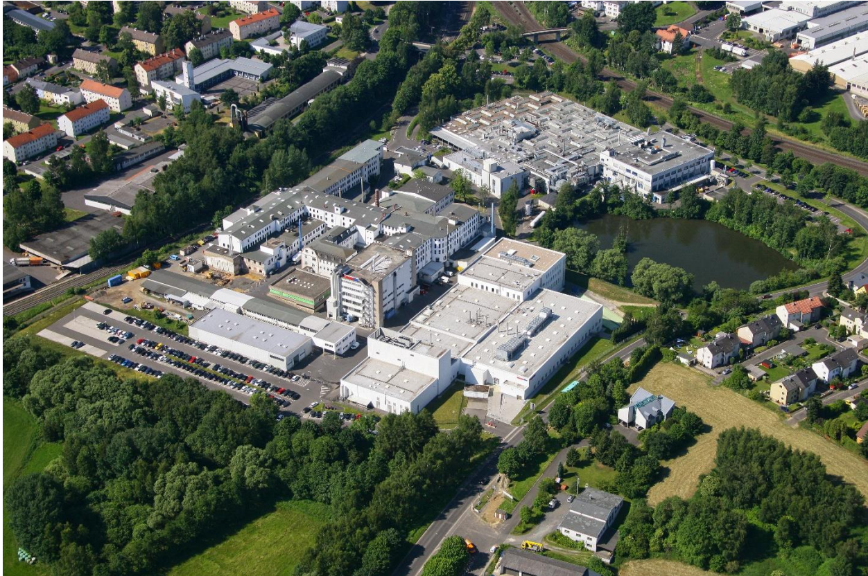
CeramTec GmbH's Marktedwitz site (Photo: CeramTec)
